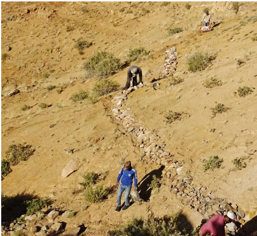
Photo : travaux d'aménagement des Bassins Versants
