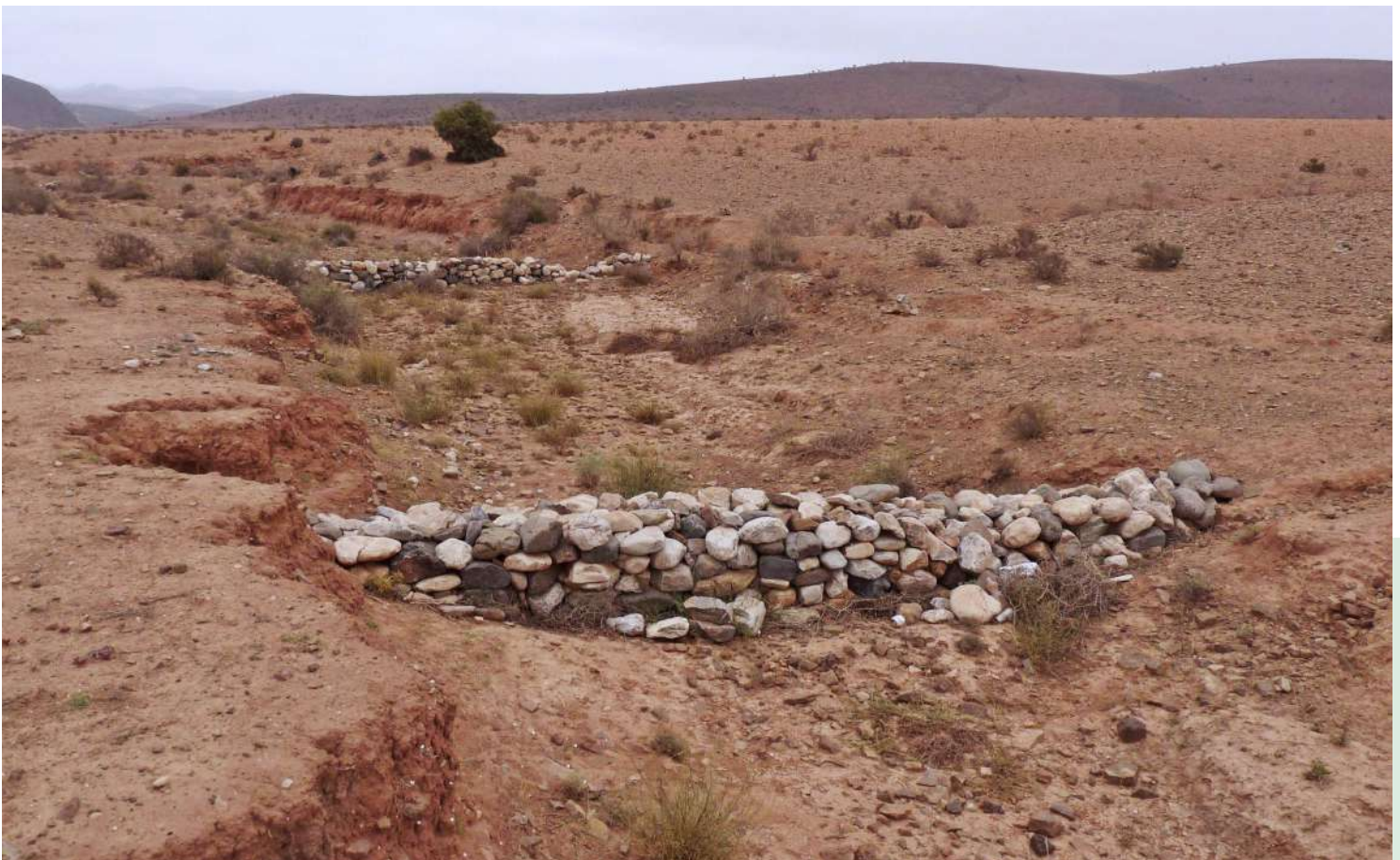
Un exemple de seuil en pierre sèche
