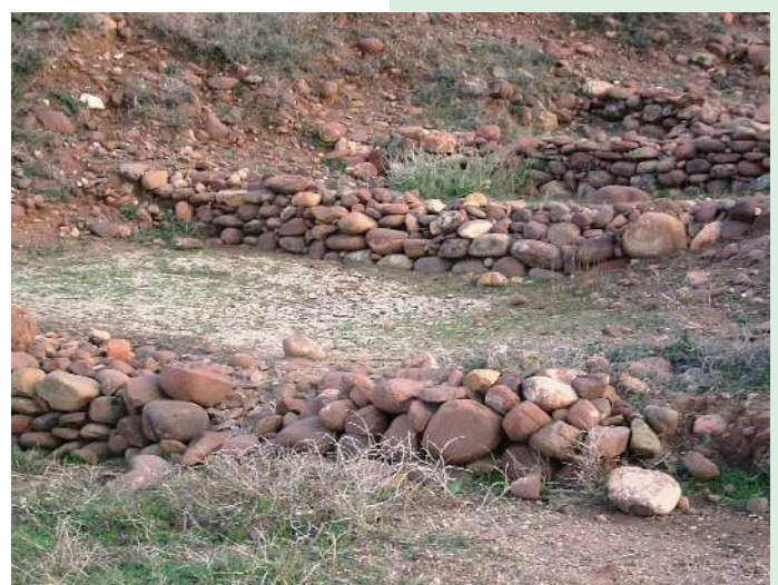
Seuil en pierres sèches ou « seuil biologique »
