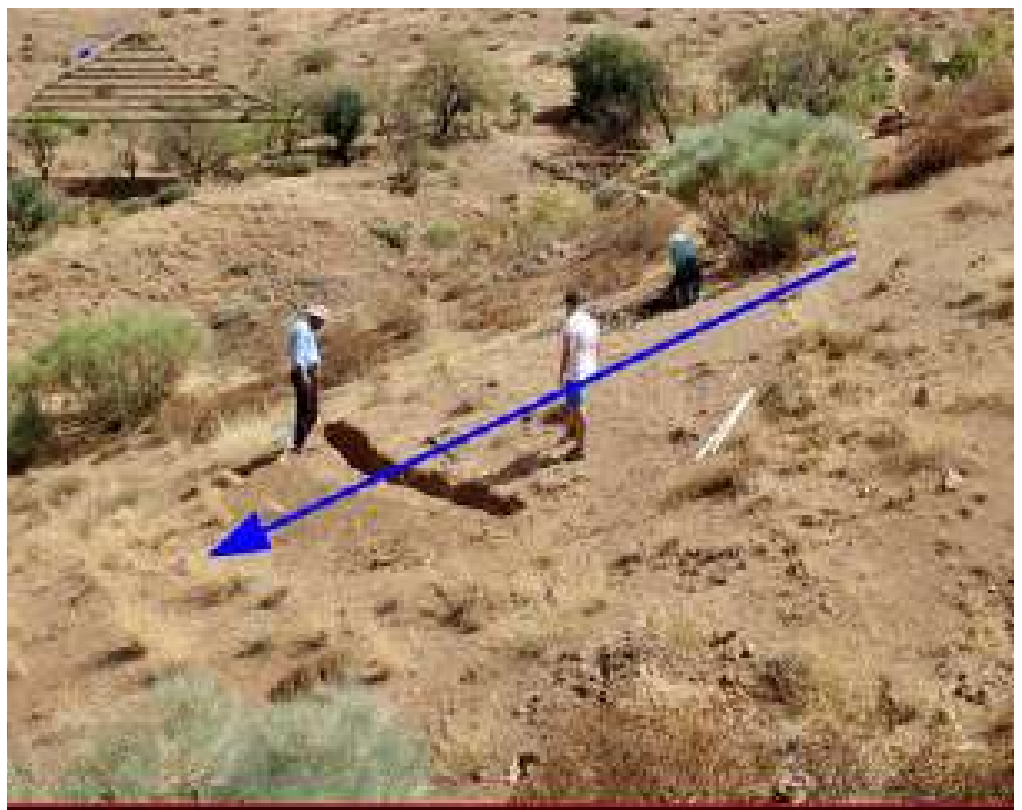
Réalisation d'une baissière. En bleu, le sens de la pente.
