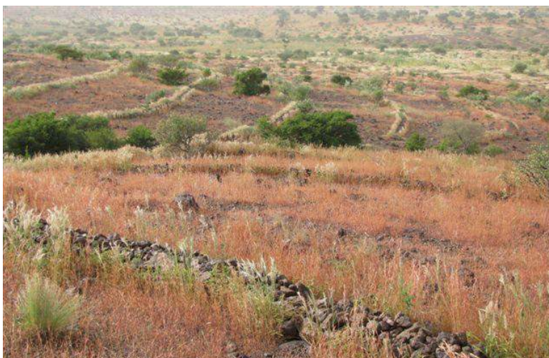
◀ Ouvrages anti-érosifs sur versants rocailloux, Village de Guidan Bouzou, commune Madaoua
