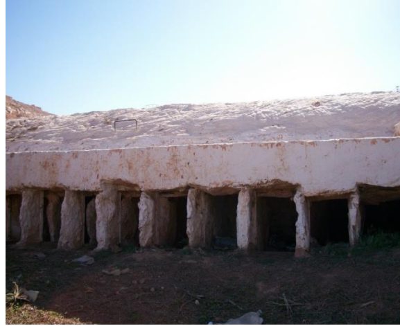
Photo 2 : répartition de l'eau
