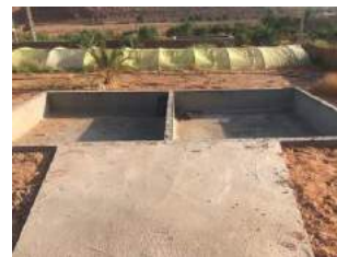
Aménagement d'une station de compostage (APEB - Beni Isguen)
