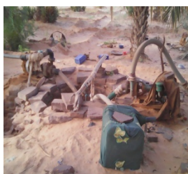
Pompage excessif : 3 motopompes pour un seul puits à Aoujeft (5 janvier 2017).
