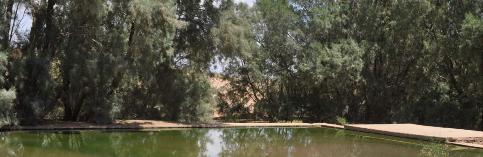
Un des trois bassins de décantation
