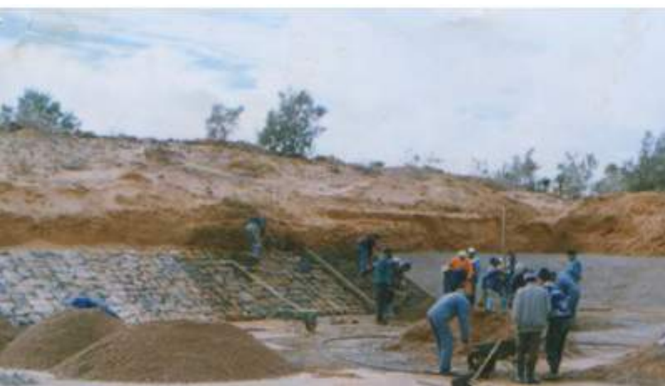
Construction d'un bassin de décantation
