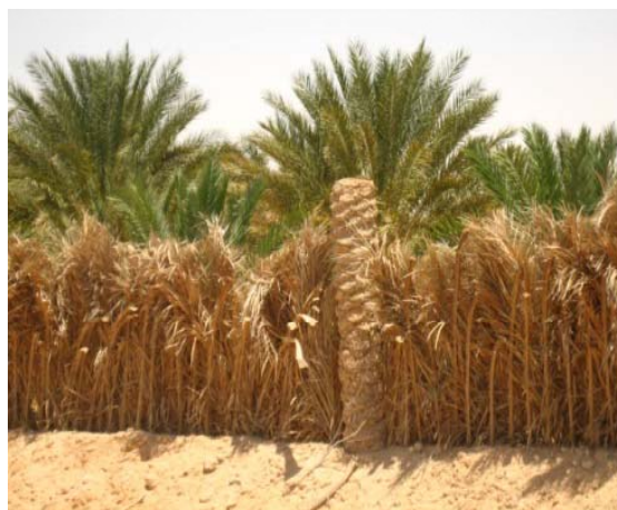
Clôture avec les sous-produits du palmier dattier et de terre locale
