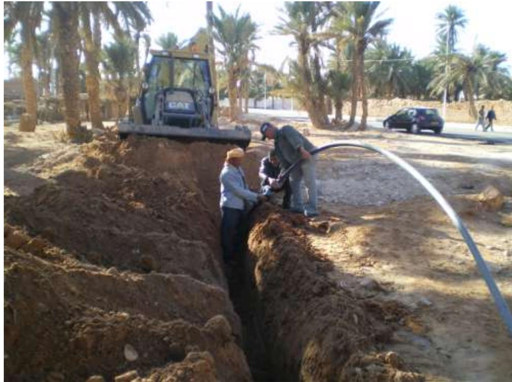
La connexion à la conduite de l'eau du barrage pour l'irrigation de la plantation agro-forestière dans la première phase du développement et d'essais du marais artificiel
