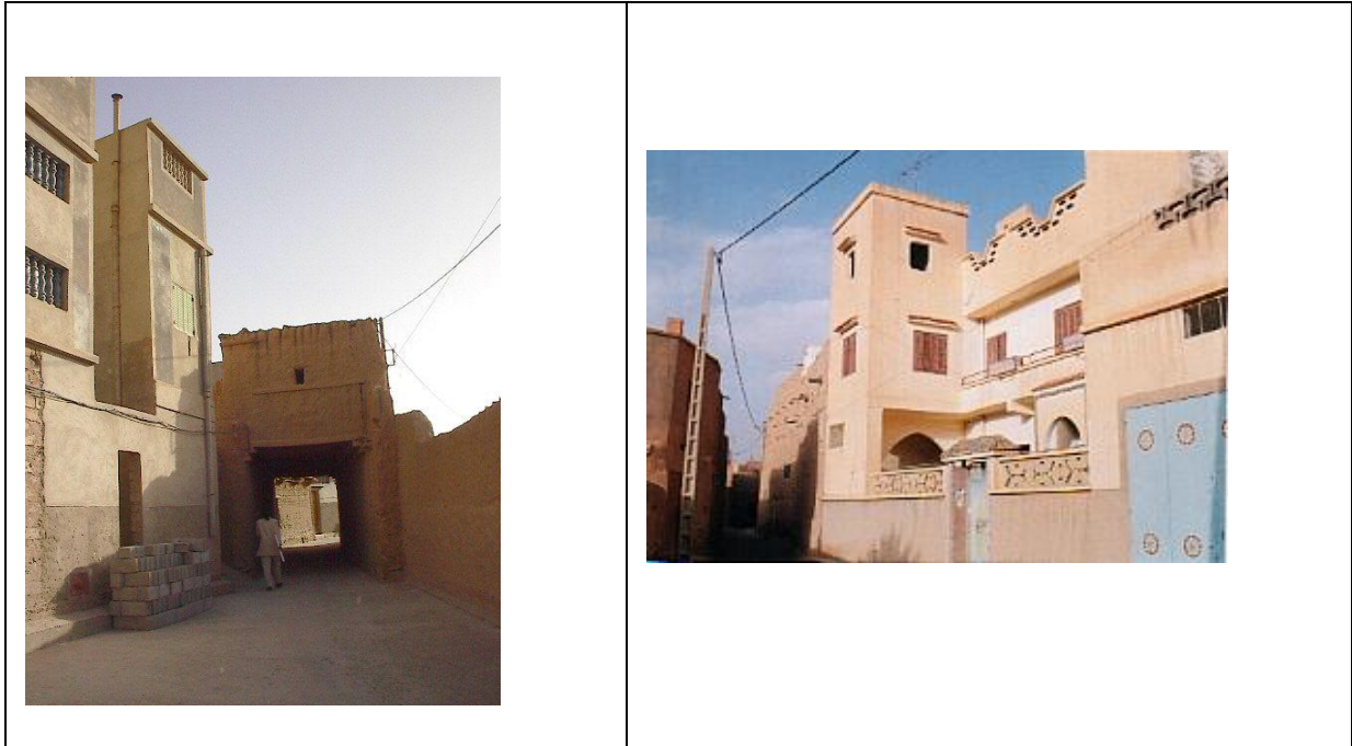
Photos15 : Exemples de maisons reconstruites en nouveaux matériaux de construction à Ksar Zenaga
