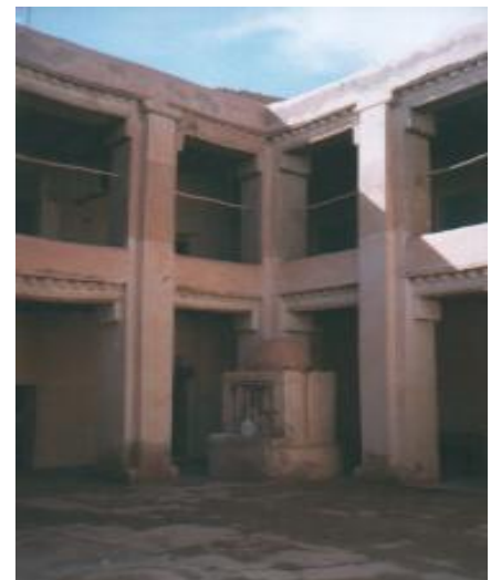
Photo9: Exemple d'un patio d'une maison au ksar Loudaghir
