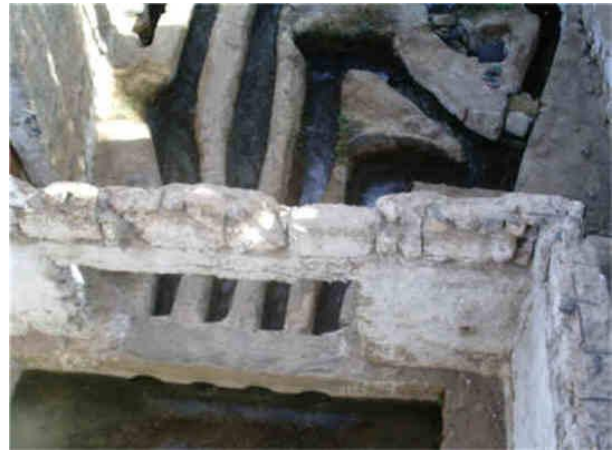
Photo18 : Les quatre répartiteurs principaux qui distribuent l'eau de la Foggara de Tzadert (Ksar Zenaga)
