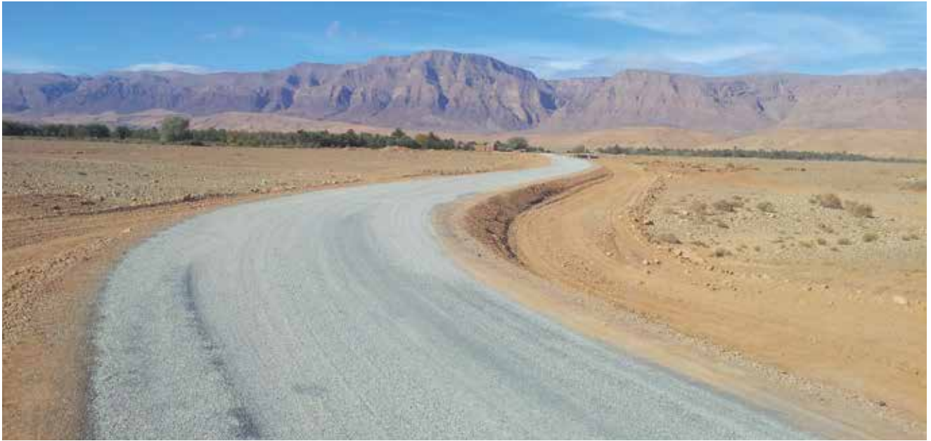
Route de désenclavement de la population de Taltefraout - CR Tadighoust
