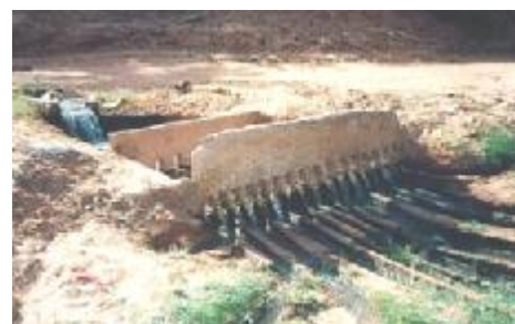
Photo n°03 : Foggara : l'eau entre les dents des peignes
