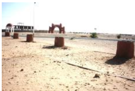
Photo n°02 : Puits des foggaras en surface au Touat
