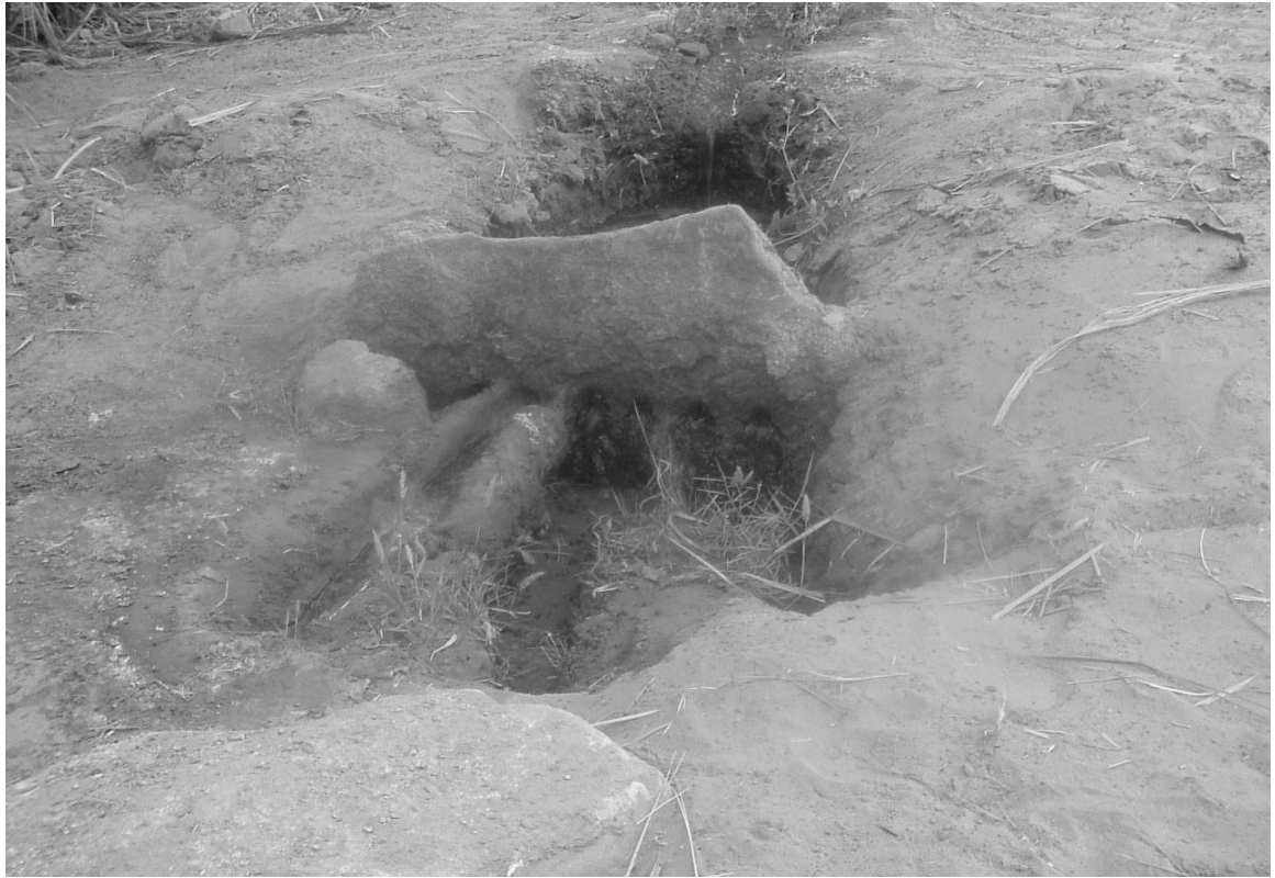
Figure 11. Kasria tertiaire de la foggara Lasalma à Timimoun (REMINI, 2008) Tertiary Kasria of the Lasalma foggara in Timimoun (REMINI, 2008).
