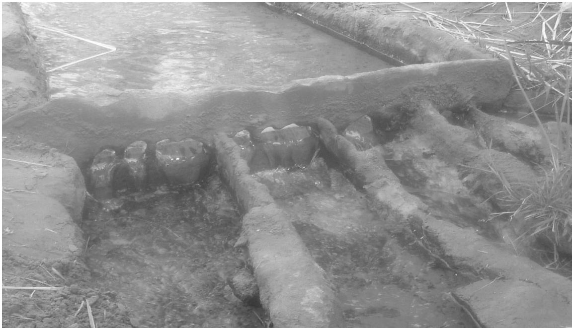
Figure 10. Kasria principale (partiteur) de la foggara Ouzziane (REMINE, 2008) Main Kasria (dispatcher) of the Ouzziane foggara (REMINE, 2008).
